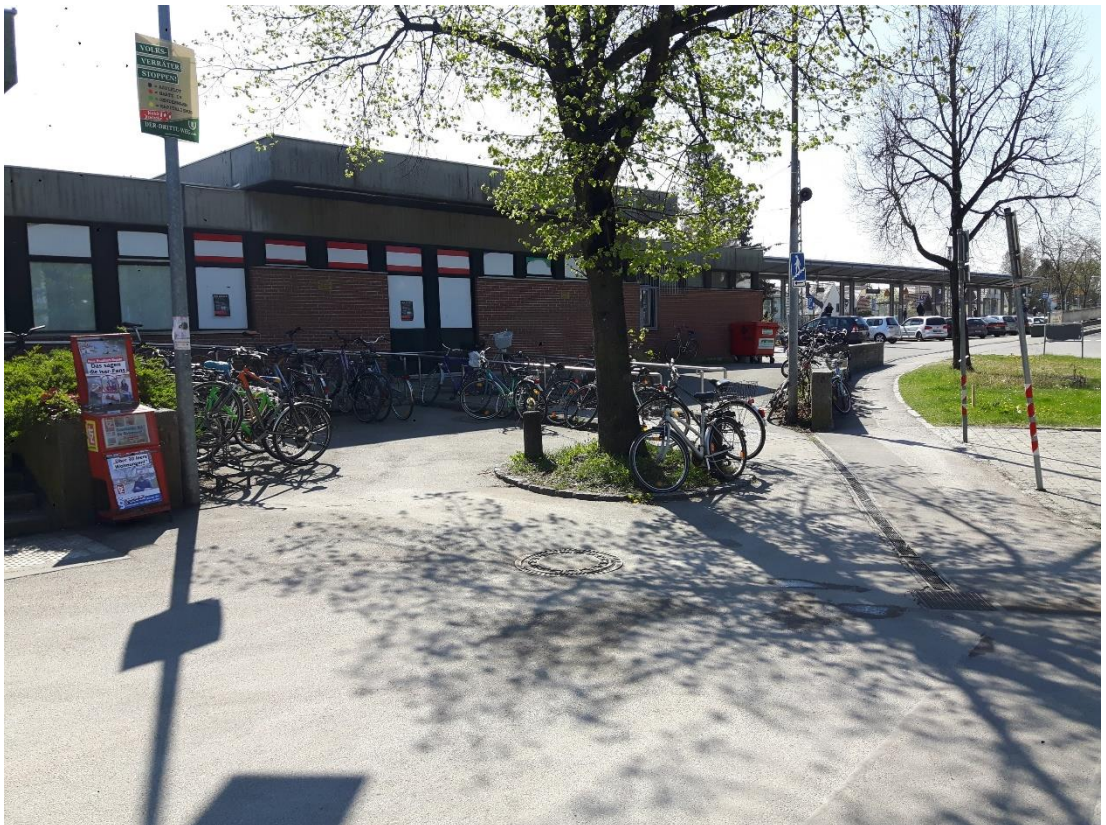
Abbildung 34: Unzureichende Fahrradstellplätze am Bahnhof (Quelle: eigene Aufnahme)
