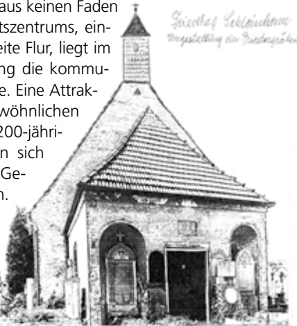
Die St.-Jakobus-Kapelle vor der Renovierung um 1960
