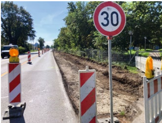
Neubau Radweg Sonnenstraße
