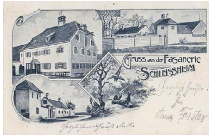
Nur noch Reste der 1945 abgebrannten Fasanerie sind vorhanden
