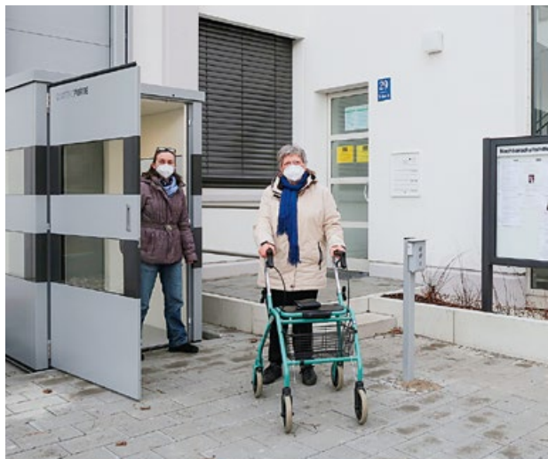
Neu gestalteter Eingangsbereich an der Theodor-Heuss-Str. 29 mit Aufzug
