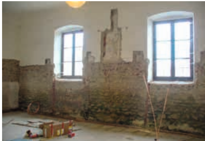
Verlegung von Kupferleitungen zur Beheizung und Trocknung des Mauerwerks (Dez. 2011).
