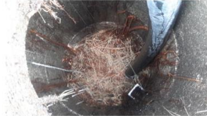
Ein Sickerschacht nach der Reinigung mit einem Hochdruck - Fahrzeug.
