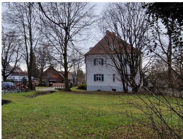
Abb. 5: Blick vom Plangebiet nach Süden auf das Pfarrhaus ohne artenschutzrechtlichen Strukturen. Eigene Aufnahme im Dezember 2024.
