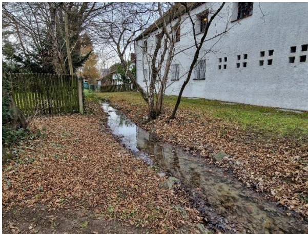
Abb. 6: Offener Kirchgraben mit Laubeintrag und Feinsedimenten bzw. Schlamm, keine Eignung als Amphibienlaichgewässer. Eigene Aufnahme (PV) im Dezember 2024.
