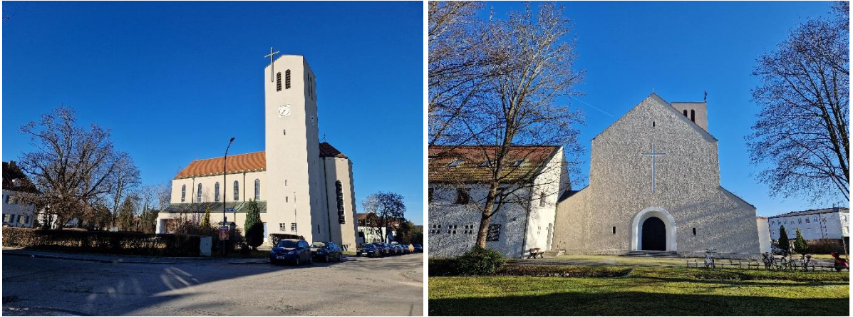
Abb. 1: Vorder- und Seitenansicht auf die kath. Kirche ohne festgestellte Quartiers- oder Einflugmöglichkeiten, pot. Öffnungen waren durch geschlossene Fenster oder Gitter/Netze verschlossen. Eigene Aufnahmen (PV) im Dezember 2024.
