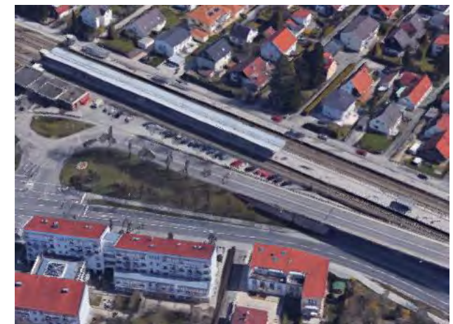
P+R am S-Bf . Oberschleißheim Quelle: www.maps.google.de
