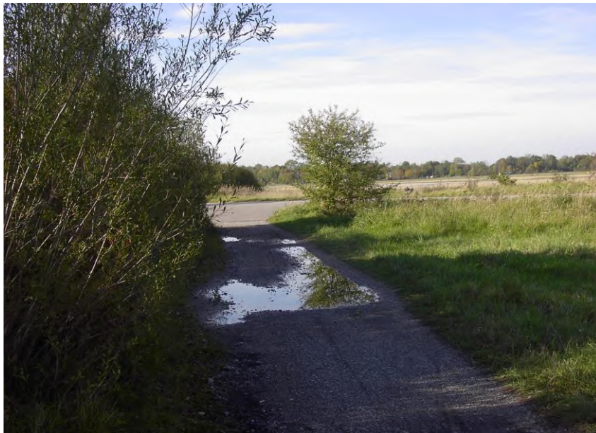
Abb. 5.7.4a: Mängel der Radfahrverbindung nach München zur Schleißheimer Straße
