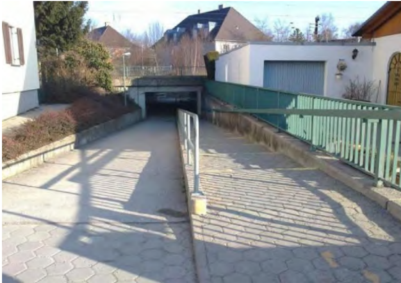
Abb. 5.5.1.1: Westseitige Rampe an der Bahnunterführung Blumenstraße
