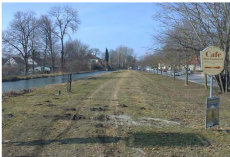
Abb. 5.1.3.6: Verlauf des südseitigen Weges auf dem Damm des Schlosskanals
