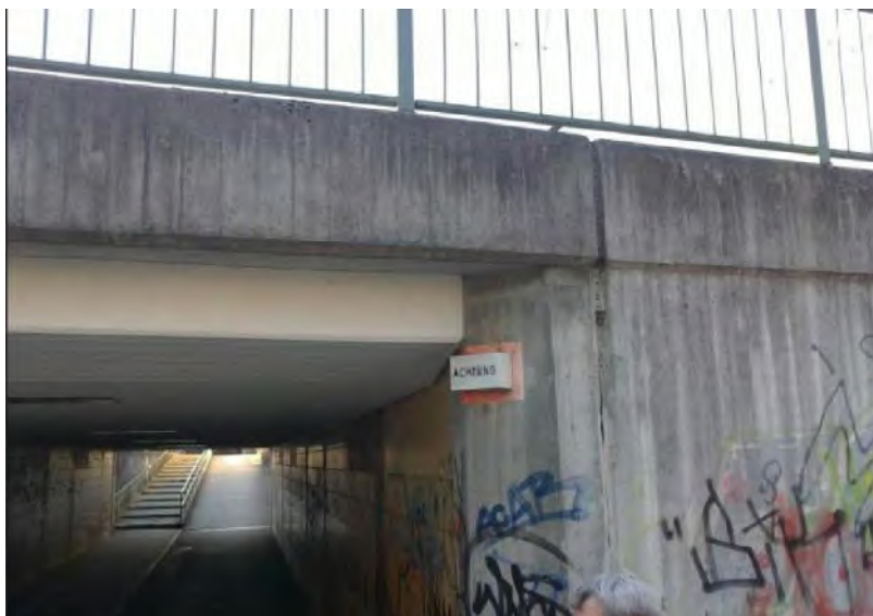
Abb. 5.5.1.2: Warnsignal an der Bahnunterführung Blumenstraße – heutige Situation
